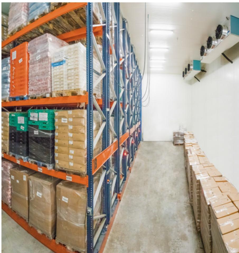
Após analisar as necessidades da empresa, a Mecalux equipou a nova câmara com cinco estantes duplas sobre bases móveis Movirack e duas fixas de 8,8 m de altura e 34 m de comprimento. Isto permitiu obter, no total, uma capacidade de armazenamento para 1.280 paletes com um peso máximo de 1.000 kg cada uma.
